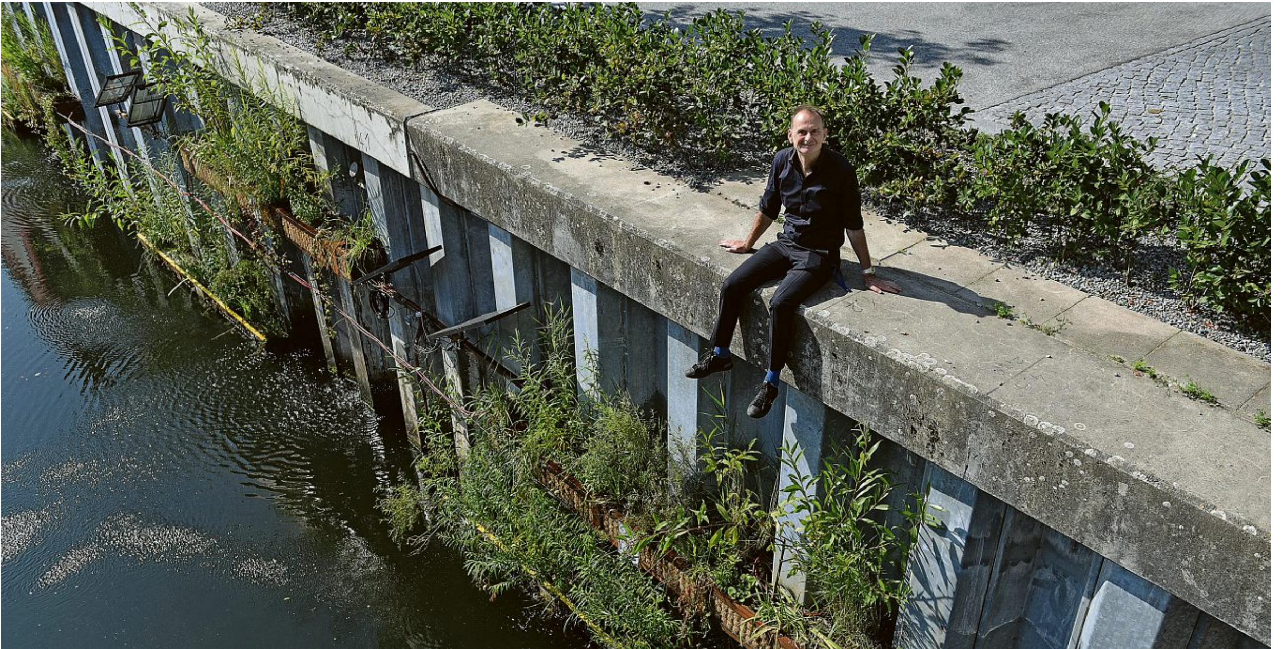
An der Kieler Brücke in Moabit hat Ingenieur Ralf Steeg eine Baukonstruktion geschaffen, die die Stahlspundwände an der Spree ökologisch aufwerten soll.
